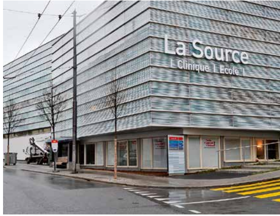
LA SOURCE CLINIC, LAUSANNE RICHTER - DAHL ROCHA & ASSOCIÉS ARCHITECTES SA
